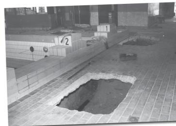
(1) En creusant plusieurs trous autour des bassins pour détecter les fuites d'eau, les services techniques de la commune constatent que les dégâts sont plus importants que prévu. L'ensemble des canalisations, oxydé par le chlore, se révèle alors hors d'usage.
