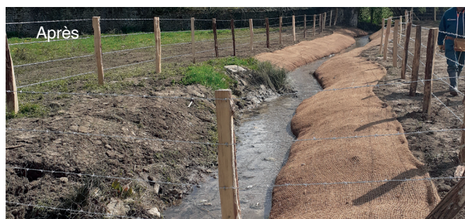
Restauration de la Sillondre à Châteauneuf-Val-de-Bargis
