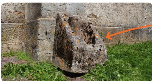
À terre, au pied du mur, nous pouvons voir un des **chêneaux** qui servaient à l'évacuation de l'eau, remplacés par des gouttières dans le projet de reconstruction de 1880. Elles doivent être changées aujourd'hui.
