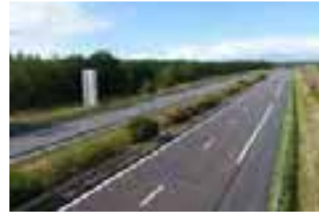
Autoroute A19 au Nord, Nord-Est et Est de l'aire d'étude immédiate
