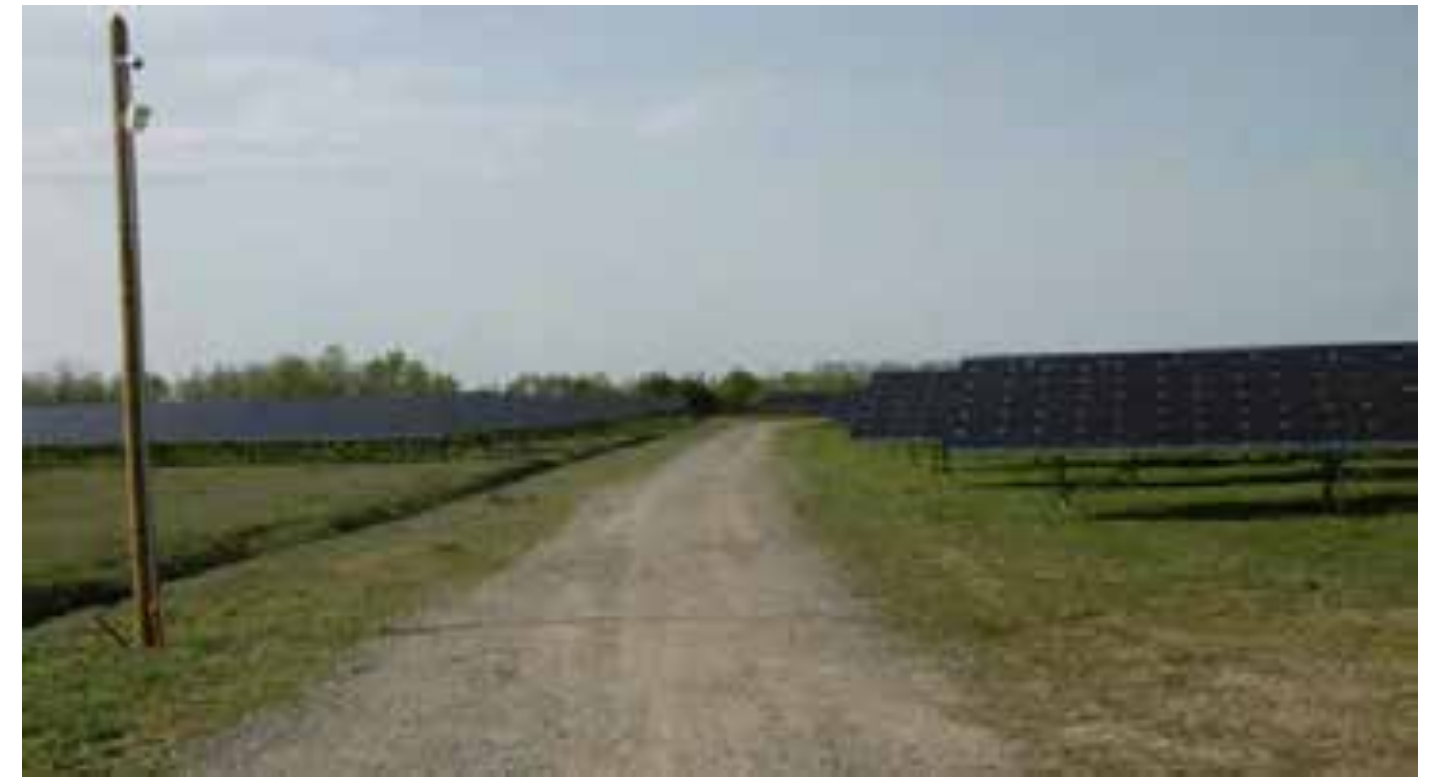
Exemple de chemin interne de parc photovoltaïque récemment aménagé (Yzeure 03)
