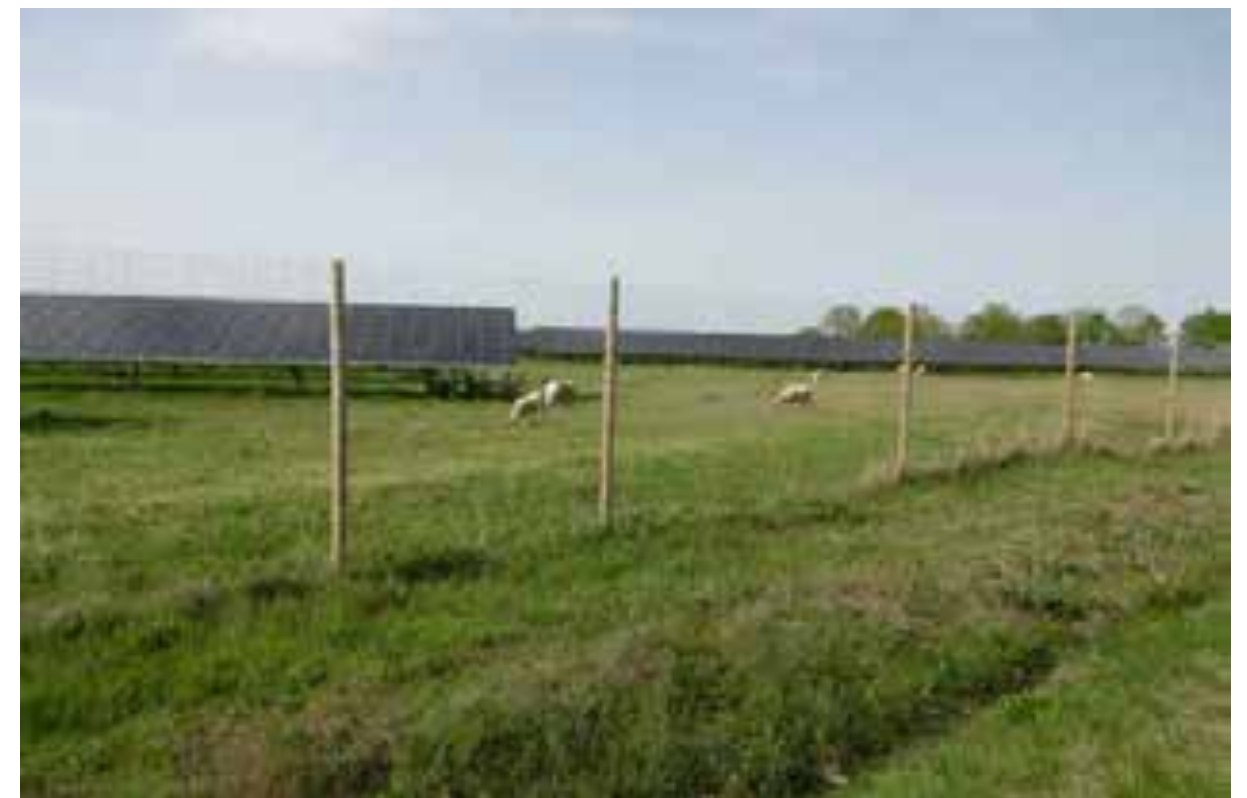
Exemple de parc photovoltaïque pâturé (Yzeure 03)
