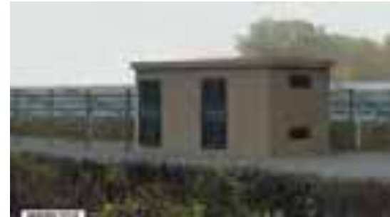
Poste de livraison Source : ABOWIND
